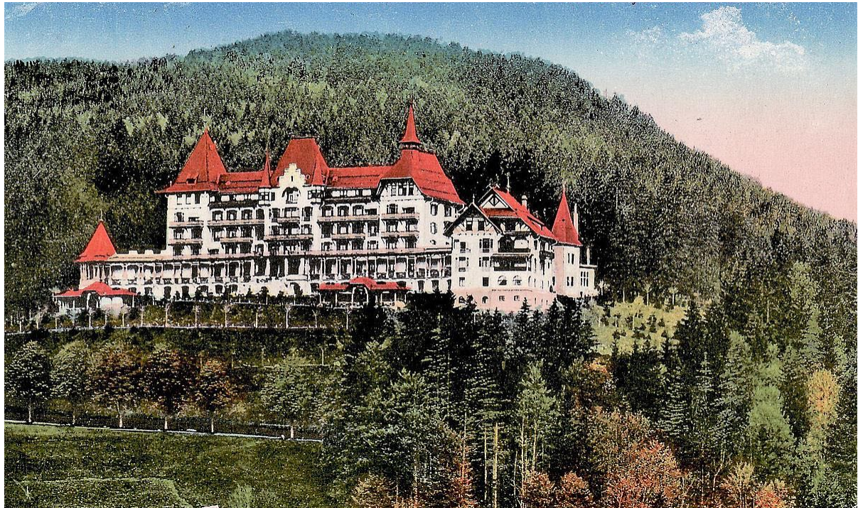
Wehrawald-Klinik in Todtmoos – Altbau vor der Sanierung
